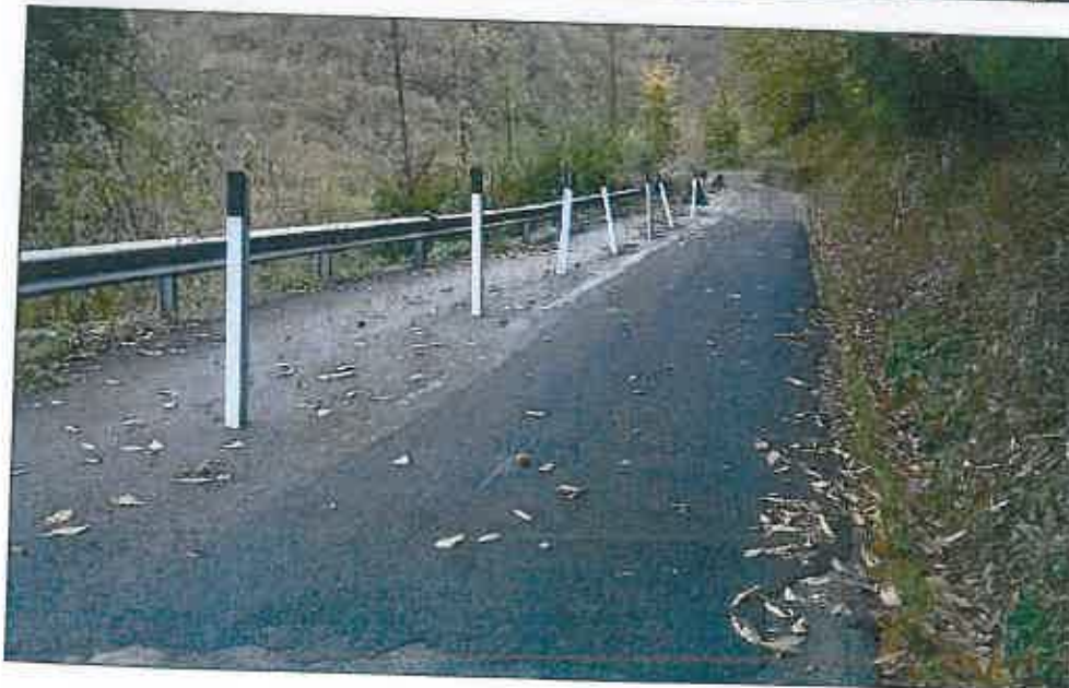
Foto 3 - Veduta verso monte del tratto di viabilità interessato dagli interventi di consolidamento. Sulla destra è visibile la cunetta alla francese che costituisce l'unica opera d'arte con funzioni di regimentazione delle acque di scorrimento superficiale.
